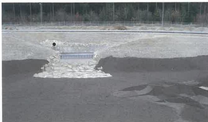
Bild 5. ENREGIS/VIVO TRP mit nachgeschalteter Biofiltrations-Substratmulde (Fotos/Abb.: Enregis)
