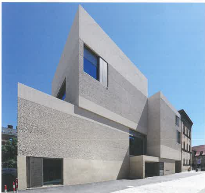
Bild 1. Im Stadtzentrum Fürths ist ein neues Wahrzeichen entstanden. Das Ludwig Erhard Zentrum erinnert mit einer Dauerausstellung an den „Vater des deutschen Wirtschaftswunders“. Der moderne Neubau setzt sich aus vier leicht versetzten Kuben zusammen.
