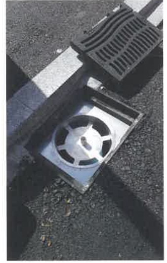
Bild 4. Filtersystem ENREGIS/VIVO CRCsorp in einen Einlaufschacht eingesetzt
