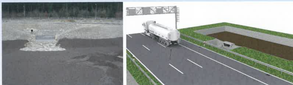
Bild 5: ENREGIS/Vivo TRP Anlage mit nachgeschalteter Biofiltrations-Substratmulde
