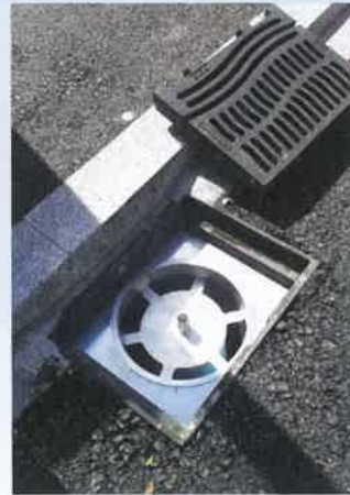
Bild 4: ENREGIS/Mivo CRCsorp, eingesetzt in einen Einlaufschacht
